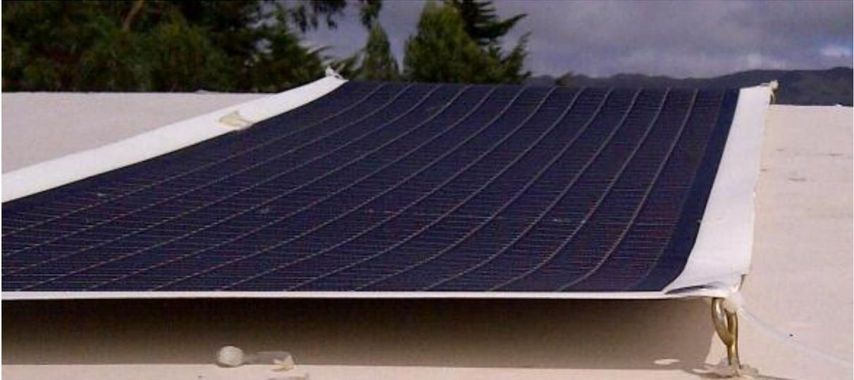
Fig. 4.9 Fijación de las láminas solares a la cubierta, utilizando cáncamos.
