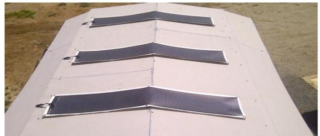
Fig. 13. Instalación de las láminas solares sobre la cubierta de la isla experimental. [Autores]
