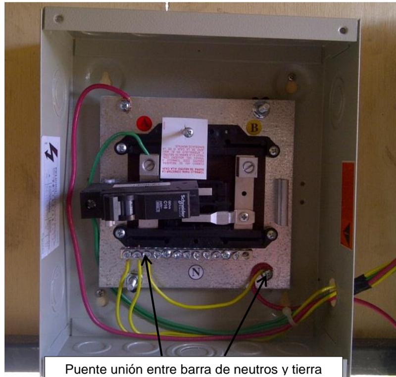
Fig. 4.13 Conexión a tierra del tablero de distribución.
