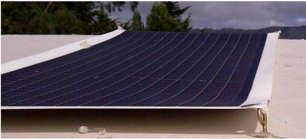
Fig. 14. Fijación de las láminas solares a la cubierta utilizando cáncamos. [Autores]
