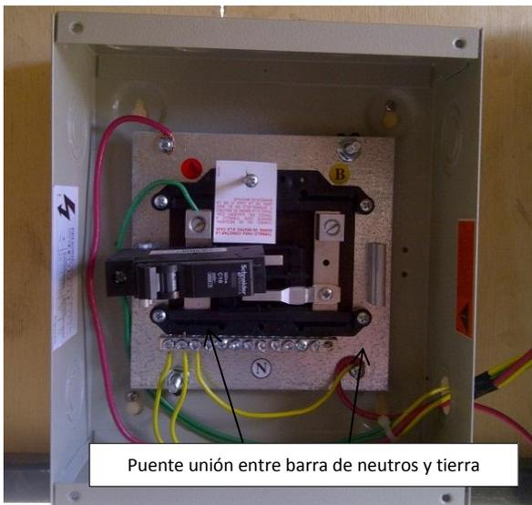
Fig. 18. Conexión a tierra del tablero de distribución. [Autores]
