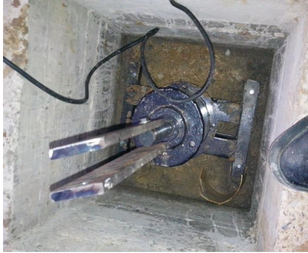
b. Cilindros emperrados en la superficie de la obra civil. Figura 3.24. Instalación de cilindros en obra civil dispuesta. Fotografías de los autores.
