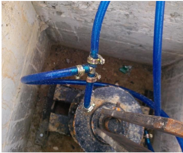
b. Colocación de uniones tipo T.
