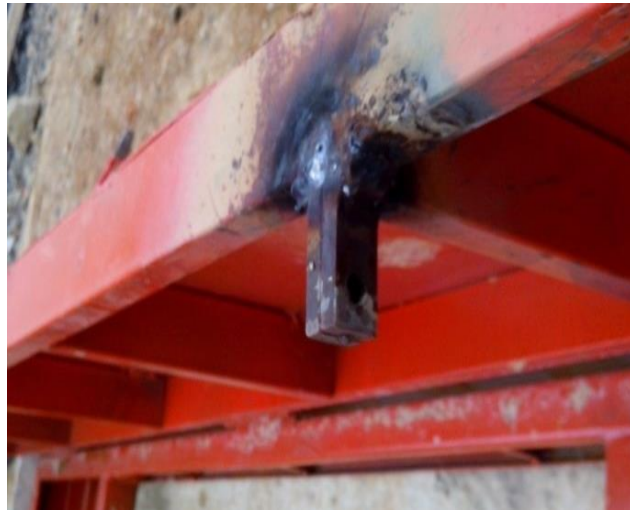
b. Acople de la plataforma para asegurar el cilindro.
