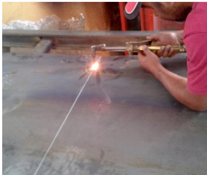
a. Corte de la plancha negra para la construcción del tanque.
