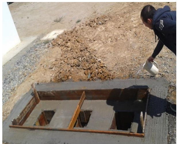
f. Hidratación del hormigón.
