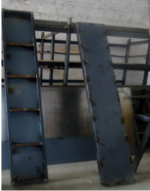
b. Construcción de cubiertas de la plataforma.
