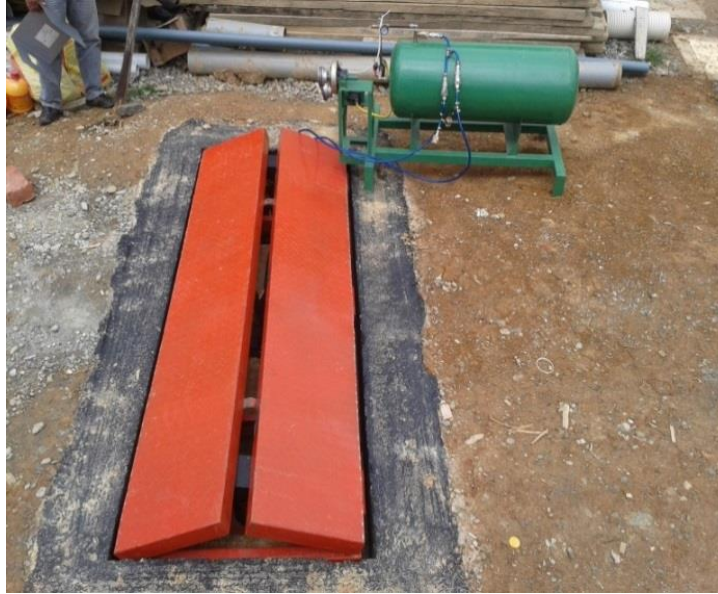
Figura 3.30. Vista general del sistema de harvesting d energía para accesos vehiculares instalado. Fotografía de los autores.
