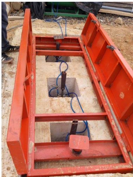
Fig. 24. Instalación de la plataforma. Fotografías de los autores.
