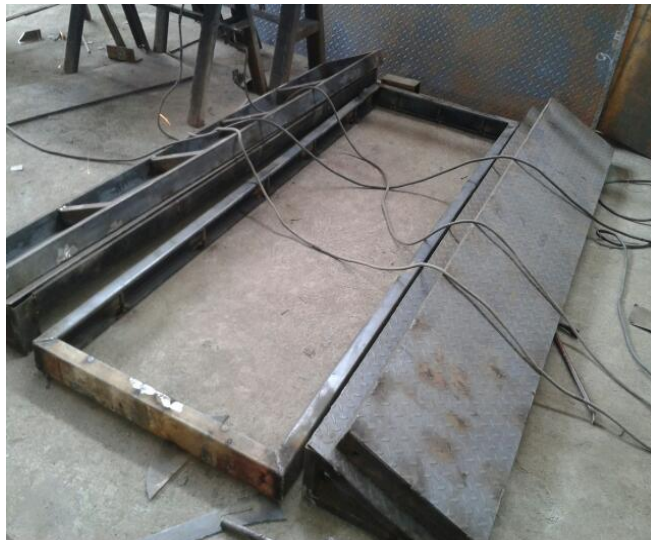
a. Construcción de la estructura base de la plataforma.
