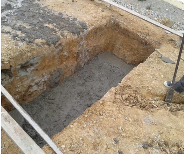
b. Fundición de la base con hormigón.
