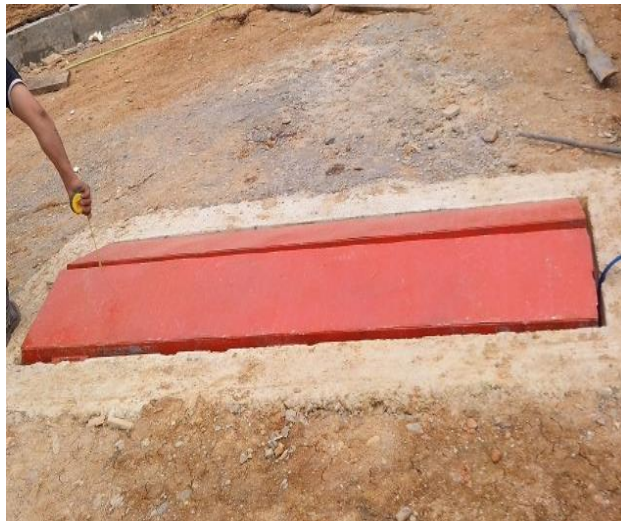
c. Vista general de la plataforma ya instalada.
