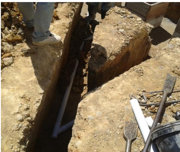
d. Colocación de tubos para drenaje de aguas lluvias.
