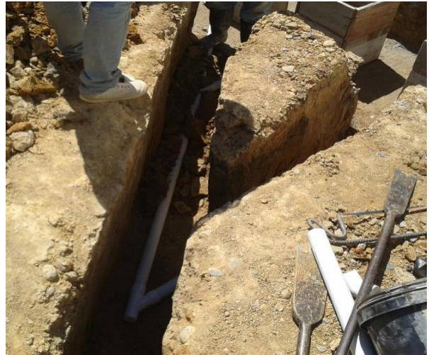
d. Colocación de tubos para drenaje de aguas lluvias.
