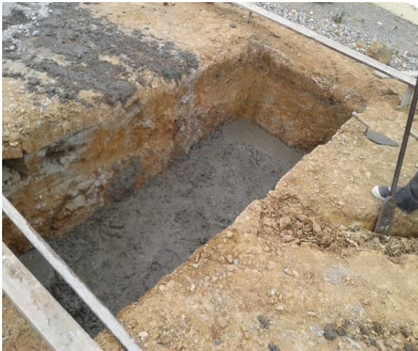
b. Fundición de la base con hormigón.
