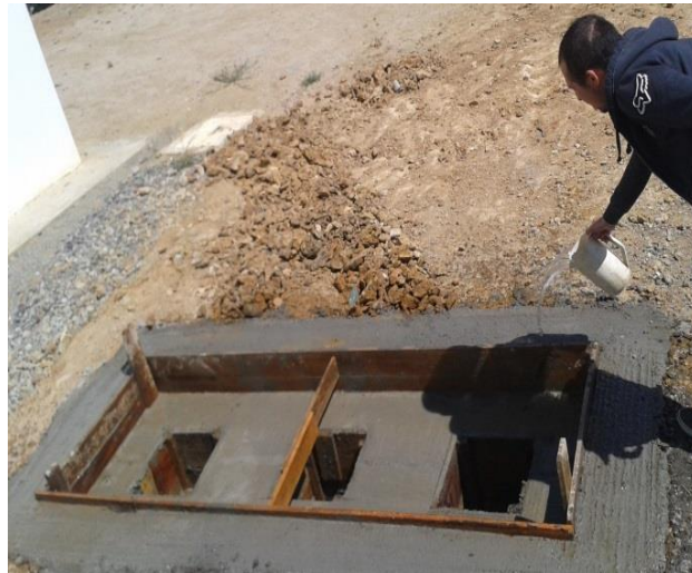
f. Hidratación del hormigón.
