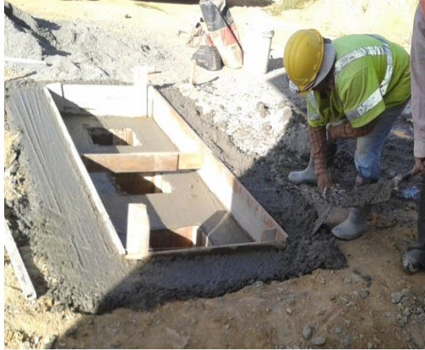
e. Proceso de relleno de hormigón.
