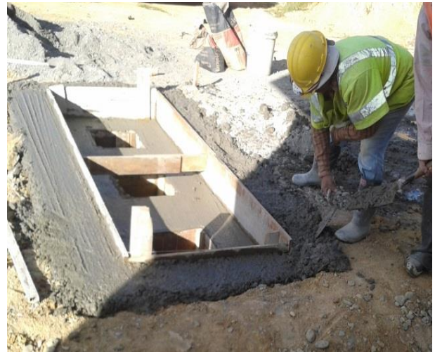
e. Proceso de relleno de hormigón.
