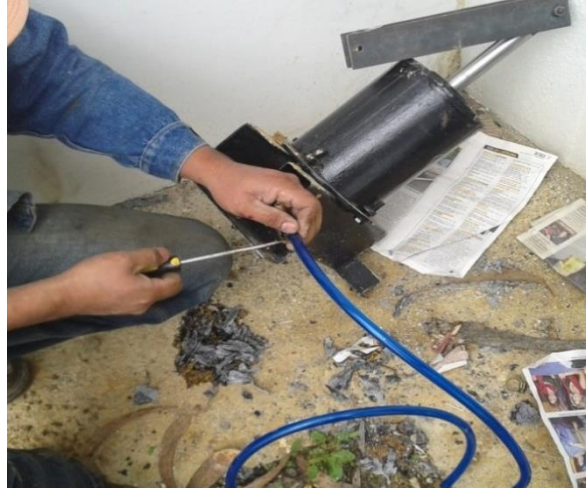
a. Adaptación de la tubería plástica en las válvulas.
