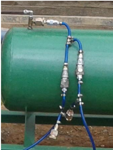
Fig. 23. Conexión de la tubería a los cilindros. Fotografía de los autores.
