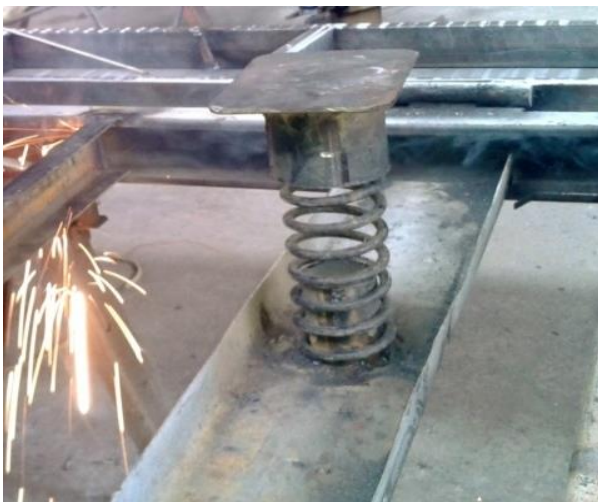
Fig. 6. Colocación de los muelles en la plataforma, con su soporte base y acople en la parte superior. Fotografía de los autores.
