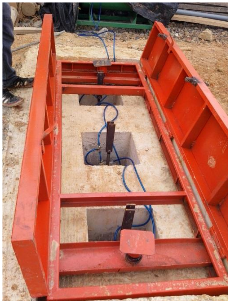
a. Colocación de la plataforma.
