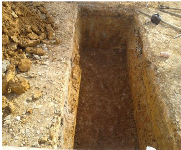
a. Excavación para la instalación del sistema neumático.
