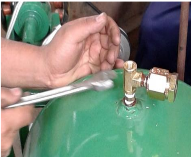
Fig. 9. Instalación de la válvula check para la entrada de aire al tanque. Fotografía de los autores.
