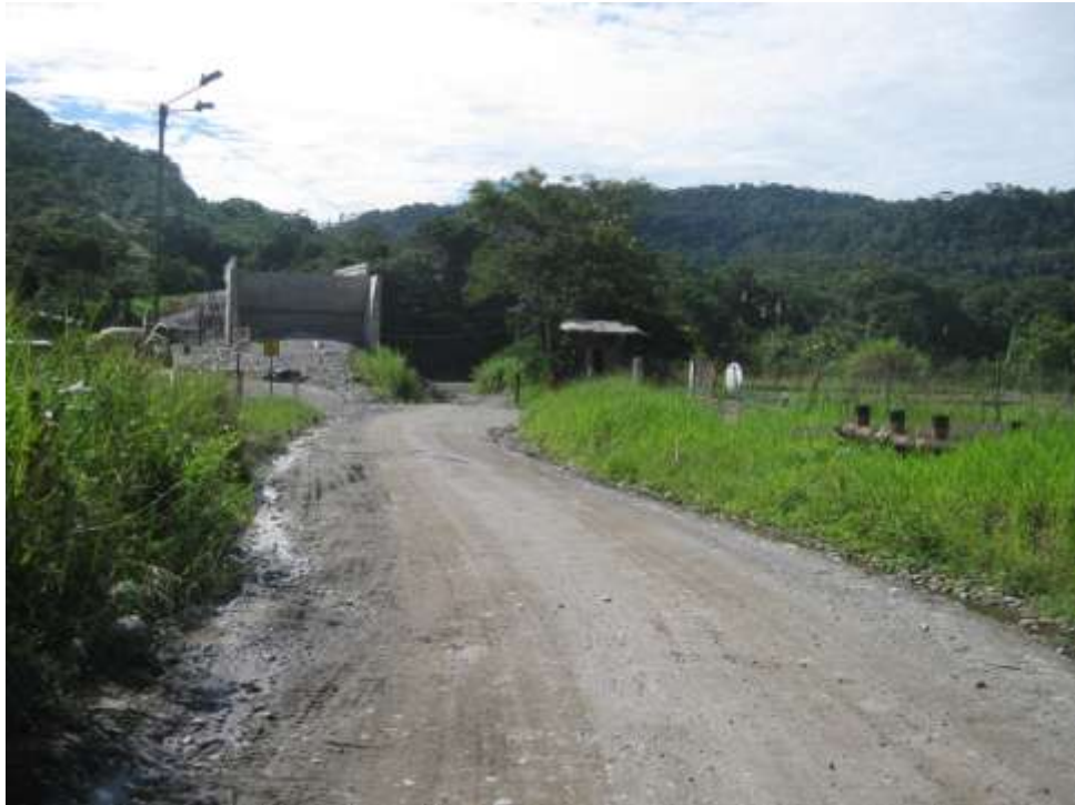
La vía no está lastrada y ese es su estado
