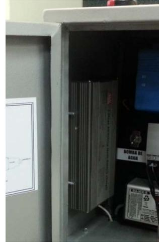
**Fig.23.** Cargador utilizado para alimentar la batería desde la red eléctrica pública. Fotografía de autores.
