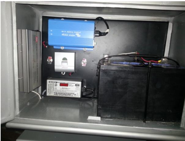
**Fig.15** Montaje de los componentes del módulo de control en la caja metálica. Fotografía de autores.
