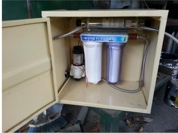
**Fig. 3.16.** Montaje de los componentes del módulo de tratamiento.
