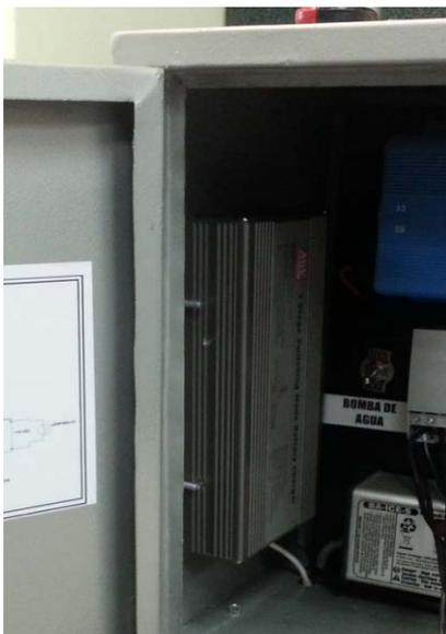
**Fig. 4.5.** Cargador utilizado para alimentar la batería desde la red eléctrica pública.
