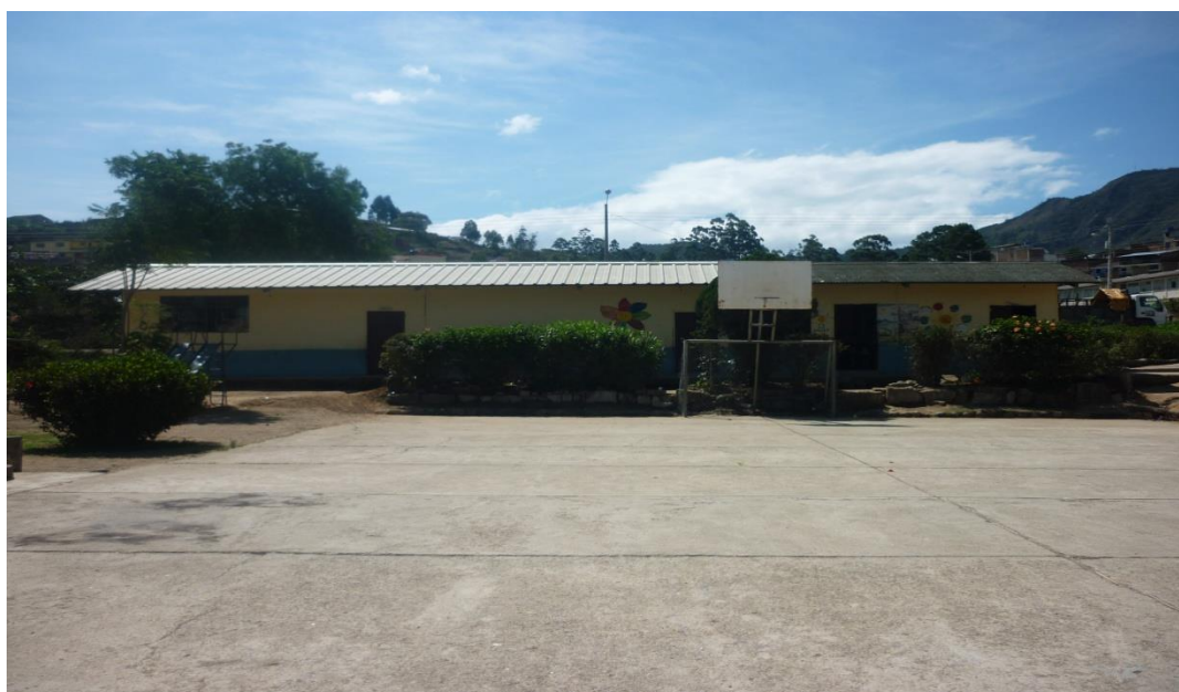
Aulas (parte posterior de la institución)
