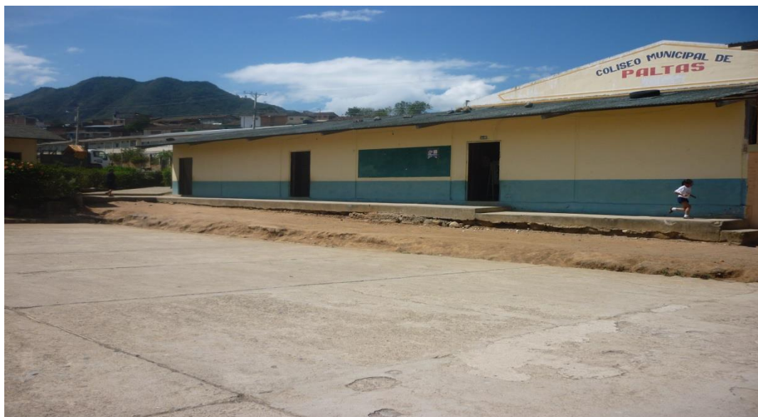
Aulas (lado derecha de la institución).
