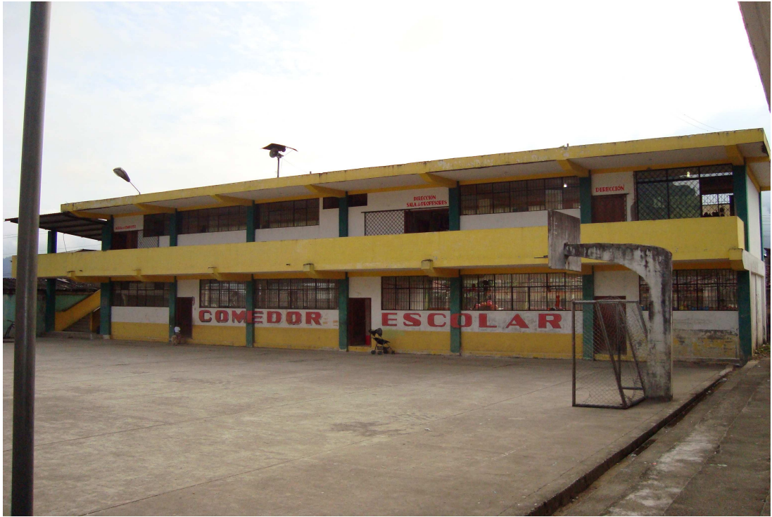
Parte de la infraestructura de la Escuela "General Rumiñahui".
