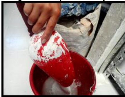
Figura 26. Preparación del yeso
