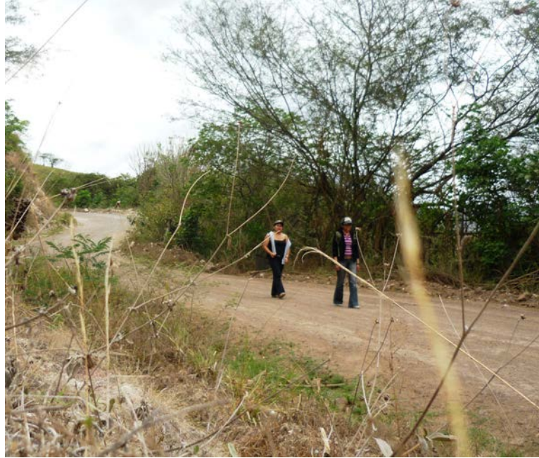
Fig.38. Carretera Vía a la Parroquia El Airo. Fuente: Las Autoras.
