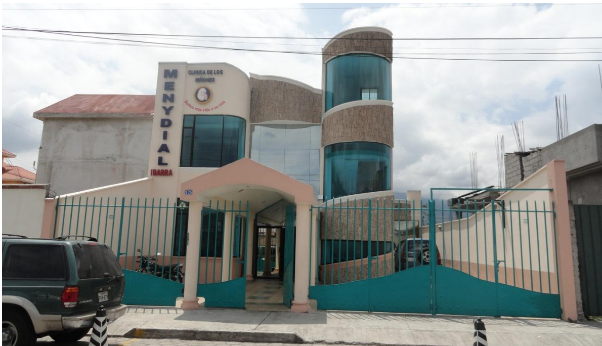
La Institución: Edificio Clínica de los Riñones Menydia Ibarra, lugar de ejecución del Plan de Acción
