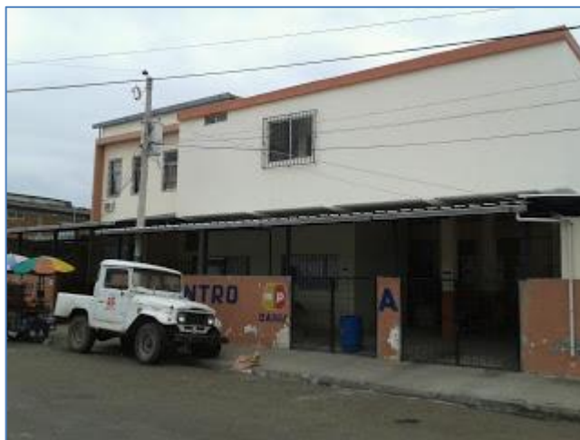
Fachada externa del Centro de Salud
