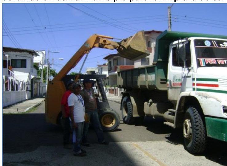
Maquinaria de GADMS en minga de limpieza
