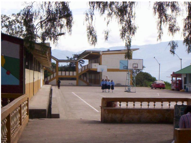
Foto N° 2. Patio principal y aulas
