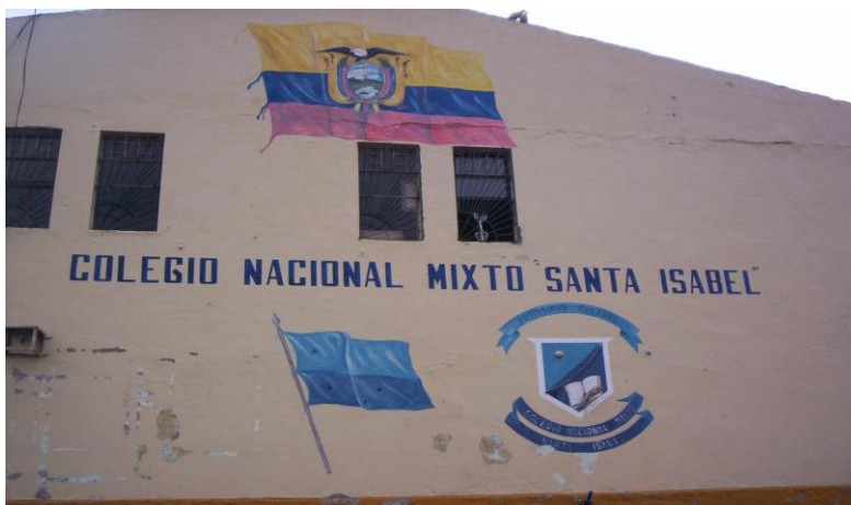
Foto N° 1.- pabellón administrativo del centro educativo
