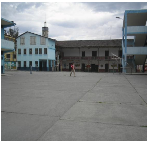
Fotografía: Escuela Fiscal Miguel Ríofrío N° 1
