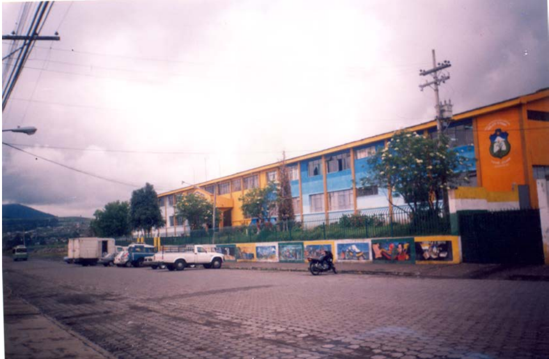
PARTE EXTERIOR DEL INSTITUTO TECNOLÓGICO "NELSON TORRES"
