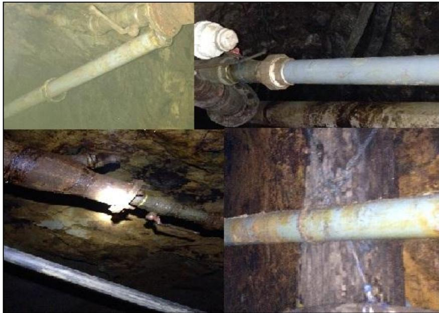
Ilustración 23. Tuberías PVC del actual sistema de ventilación
