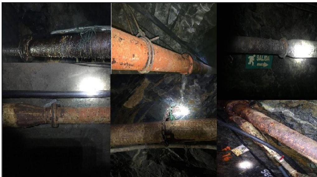
Ilustración 24. Tuberías hierro del sistema actual de ventilación.
