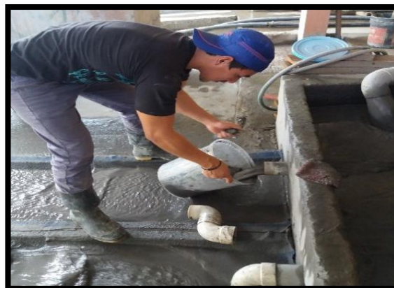
Ilustración 28. Toma de datos de caudal.
