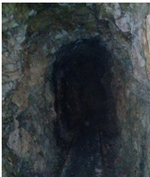
Figura 5 Galería, Frente 4. Fuente: Gonzalo Mora Mora Elaboración: Gonzalo Mora Mora
