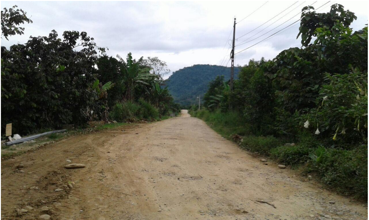
Calle de acceso a los barrios
