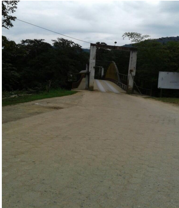
Puente de ingreso a la parroquia
