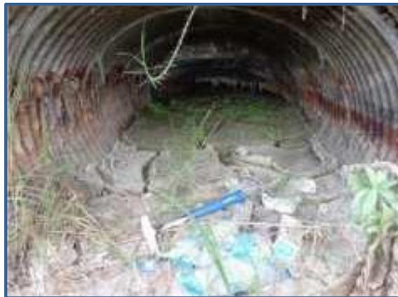
**Figura 21.** Alcantarilla colapsada y colmatada con sedimentos
