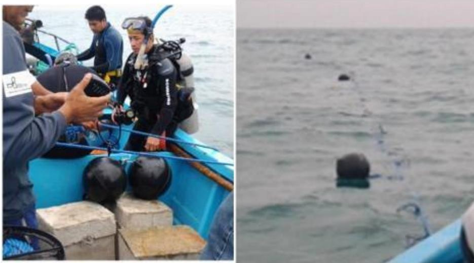
Figura 30. Instalación de línea de cultivo (a) Colocación de bloques (b) lanzamiento y alineación del sistema
