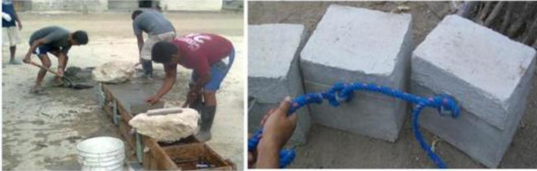
Figura 28. Construcción de bloques de hormigón armado para anclaje (a) Elaboración de los bloques, (b) Amarre entre bloques
