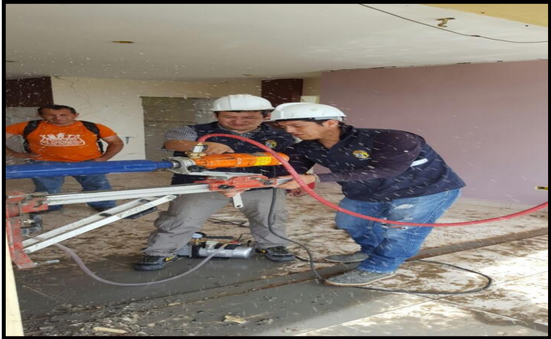
Fotografía 11: Extracción de núcleos en edificios de la zona de estudio.
