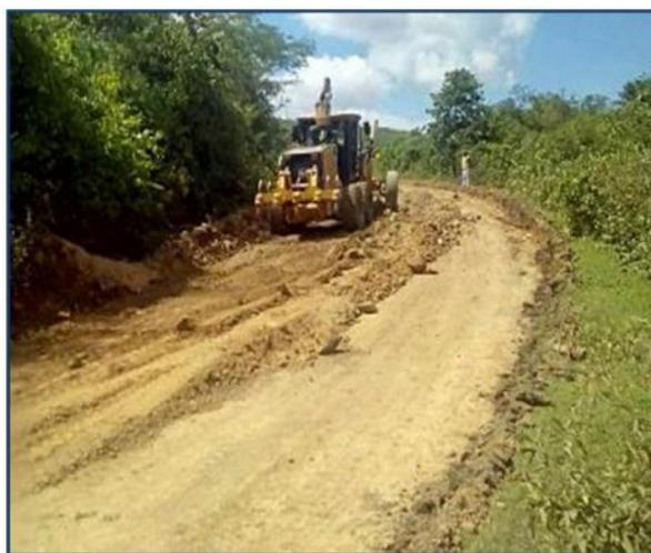
Imagen 1. Escarificación, aireación de subrasante vía Pindal-Paletillas
