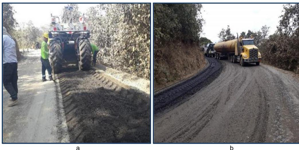
Imagen 10. (a, b): Tendido de material de base estabilizada con emulsión asfáltica, vía Pindal-Paletillas
