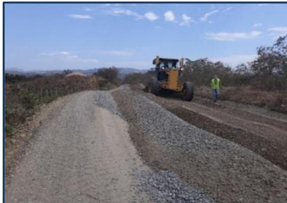
Imagen 6. Tendido de material de subbase clase III, vía Pindal-Paletillas
