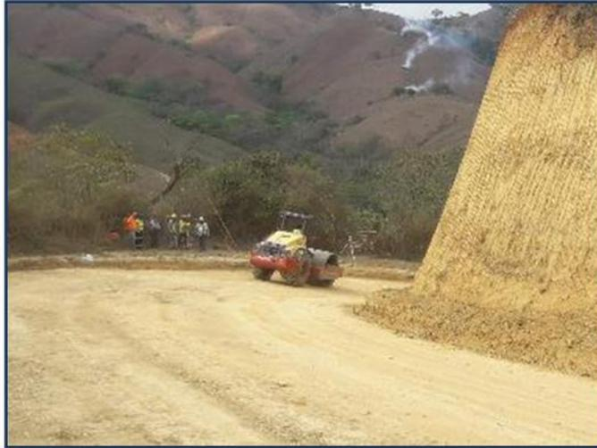
Imagen 3. Compactación para conformación de acabado de obra básica, vía Pindal-Paletillas
