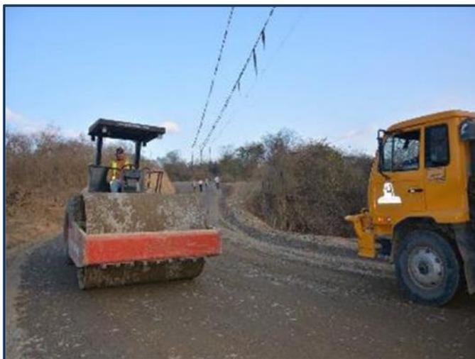
Imagen 7. Compactación de material de subbase clase III, vía Pindal-Paletillas
