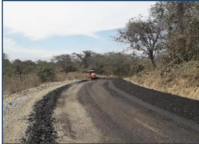
Imagen 13. Compactación de material de base con emulsión asfáltica, vía Pindal-Paletillas
