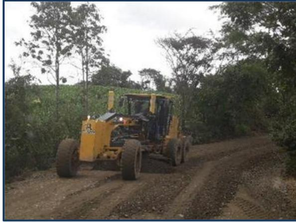
Imagen 5. Tendido de material de subbase clase III, vía Pindal-Paletillas
