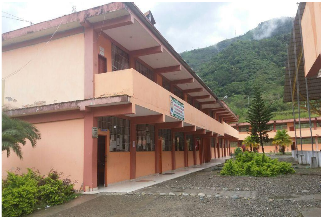
Fotografía N° 2. Estructura física de la Unidad Educativa "12 de Febrero" (parte interna) Elaborado por Sánchez (2017)
