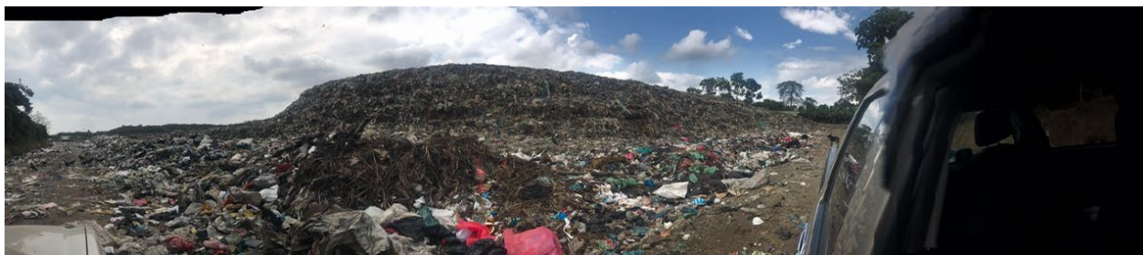
Imagen 12. Estado actual del relleno sanitario
