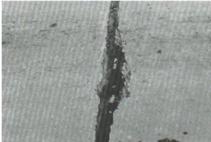
Figura 6. Daño del sello de junta severidad media
