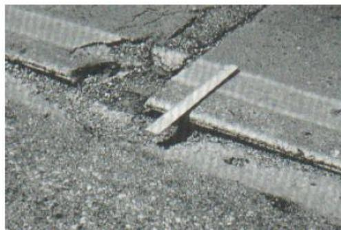
Figura 7. Desnivel carril/berma, severidad baja
