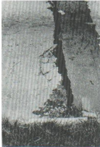
Figura 1. Falla blowup-buckling severidad baja
