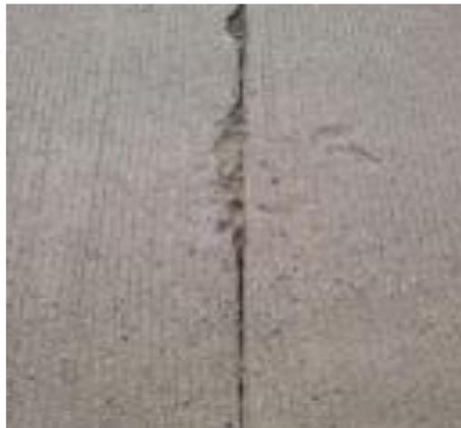
Figura 19. Descascaramiento de junta
