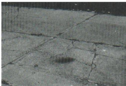
Figura 3. Losa dividida severidad alta
