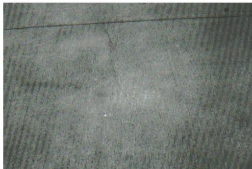
Figura 17. Grietas de retracción
