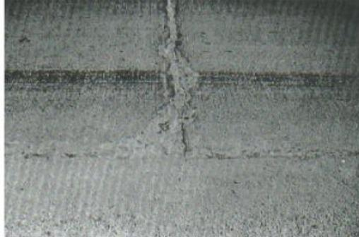
Figura 18. Descascaramiento de esquina
