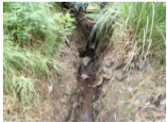
Detalle del agua drenada del bloque.
