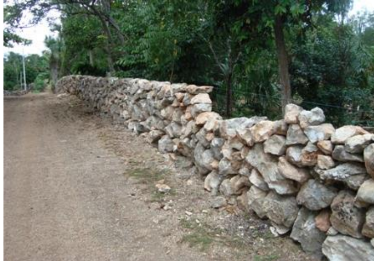
Figura 23: Mampostería sin mortero Fuente: (Araujo Molina, s. f.) Elaboración: El Autor
