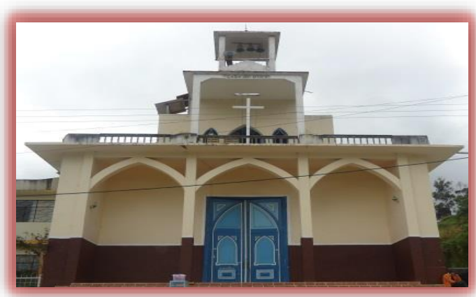
Figura N°15: Foto Iglesia San Lucas
