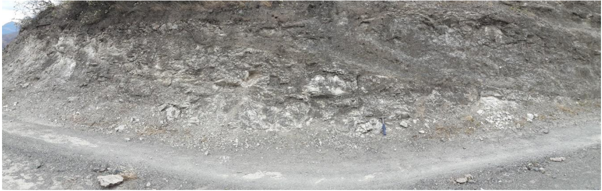
Figura 19.- Riolita aflorando en vía y corte de vía.
