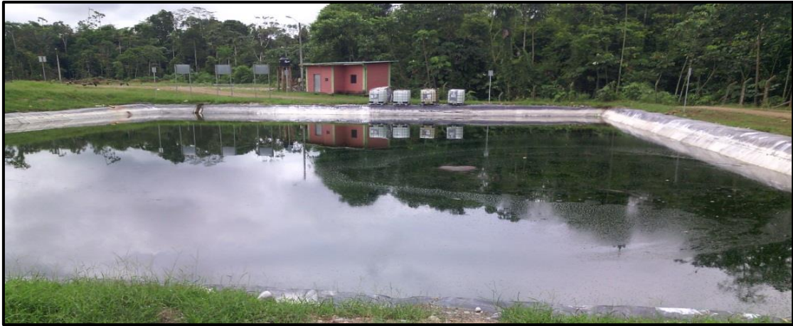
Figura 14: Piscina de lixiviados de tratamiento.
