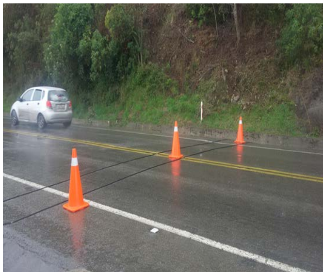
Figura 9. Colocación de sensores en estación primaria Nro. 2:km 12+600 Fuente: Imagen tomada por el autor Elaborado por: Autora
