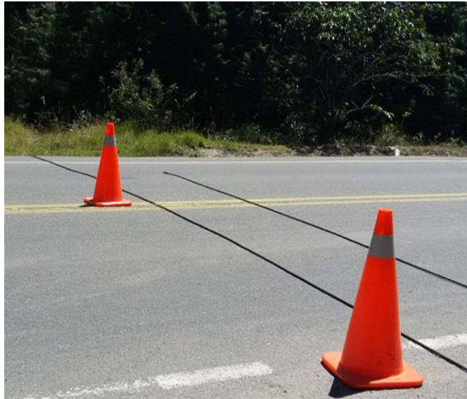
Figura 7. Estación primaria Nro. 1 en km 7+100. vía Loja - Catamayo Fuente: Imagen tomada por el autor Elaborado por: Autora
