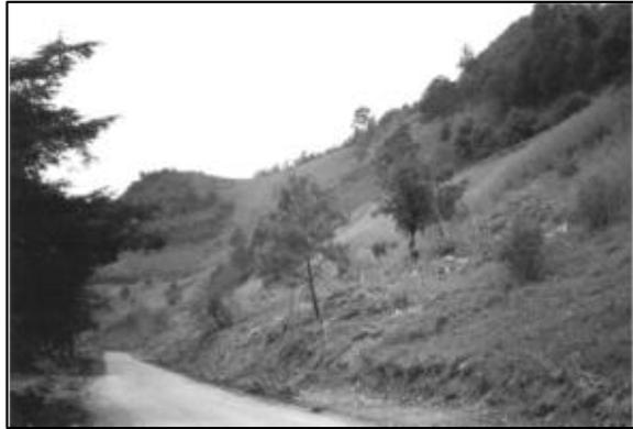
Figura 3. Deslizamiento traslacional en talud de vía
