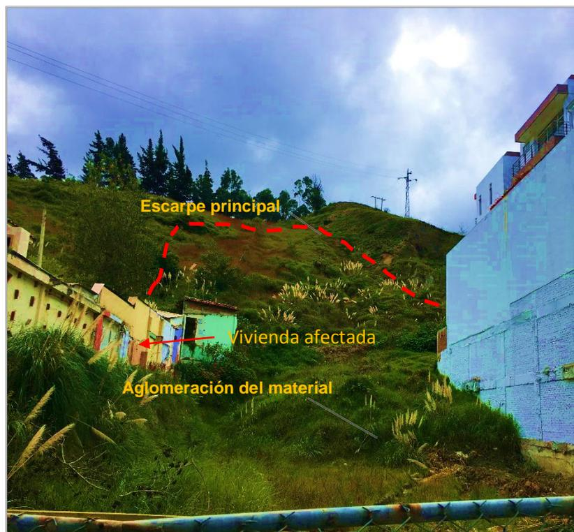
Figura 23. Material deslizado al pie del talud
