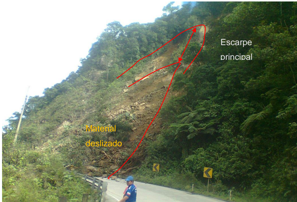
Figura 2.7: Deslizamiento traslacional en el kilómetro 35+850. Fuente: Ministerio de Transportes y Obras Públicas (2017) Elaborado por: Marco Antonio Álvarez
