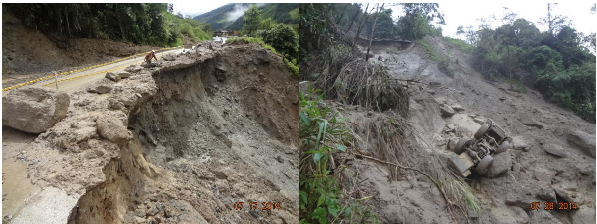
Figura 3.8 Movimiento en masa complejo (movimiento traslacional en cabecera y flujo de pie) en la abscisa 44+200. Fuente: Marco Antonio Álvarez Elaborado por: Marco Antonio Álvarez
