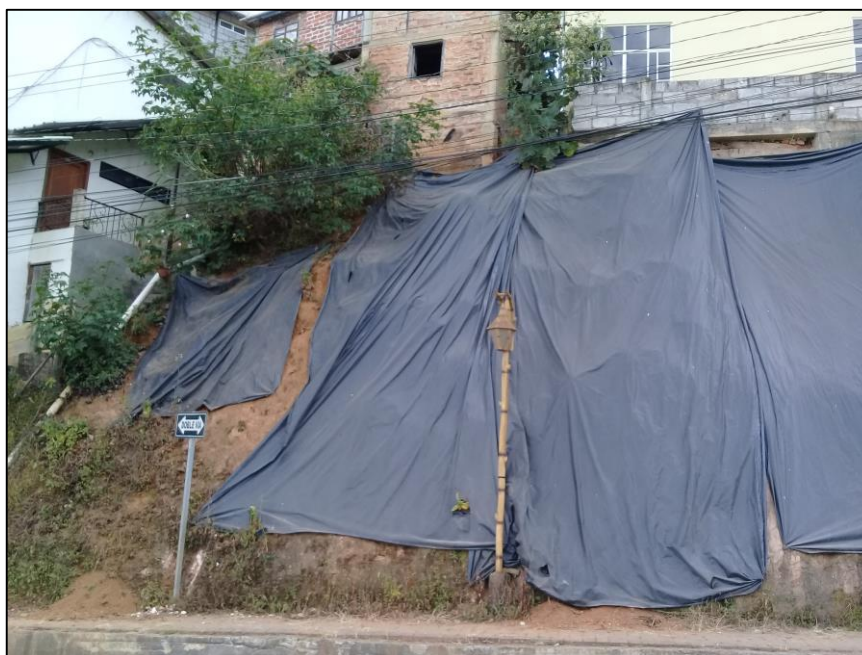
Foto 17: Impermeabilización de taludes con plásticos. Calle Gonzalo Pizarro.
