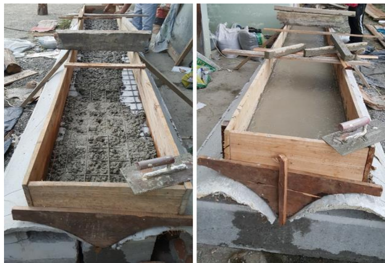
Figura 5.6: Colado del hormigón.
