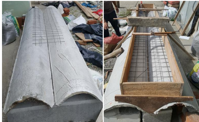
Figura 5.5: Armado del prototipo de entrepiso.
