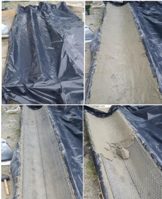
Figura 5.3: Proceso de colado del mortero.
