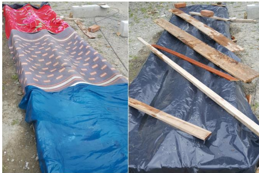
Figura 5.4: Curado de las Losas prefabricadas de ferrocemento (LPF)
