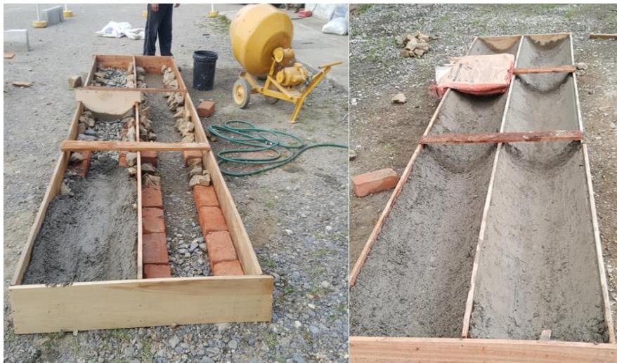
Figura 5.1: Conformación del molde parabólico de hormigón simple.
