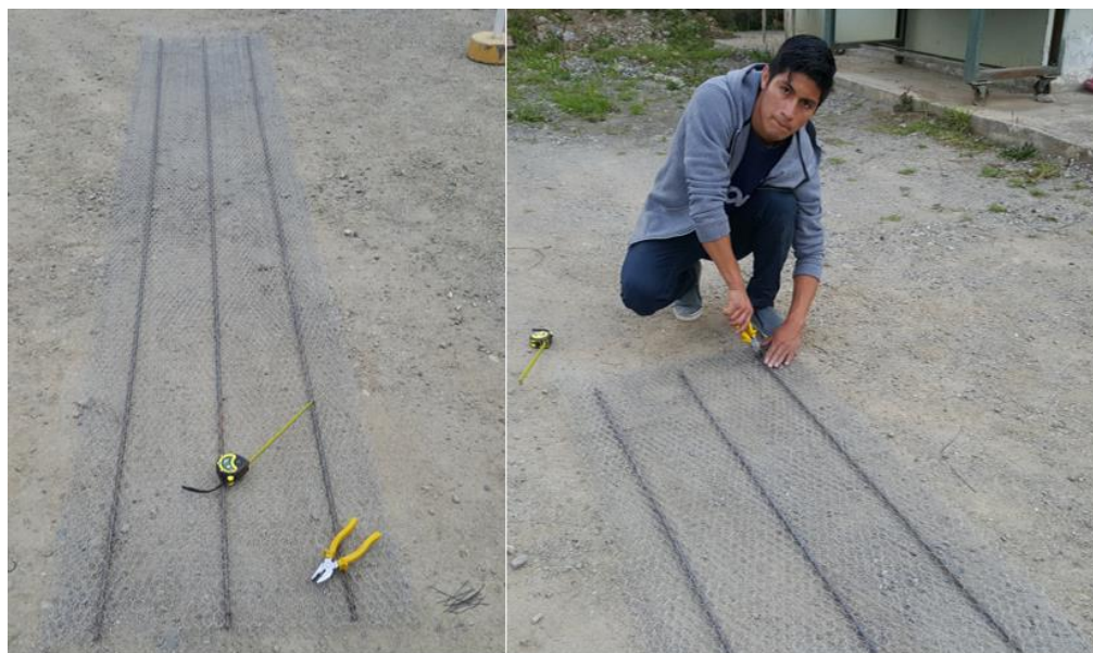
Figura 5.2: Armado de las mallas y acero de refuerzo.
