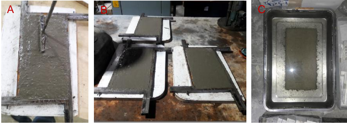
Figura 80. Realización de paneles.
