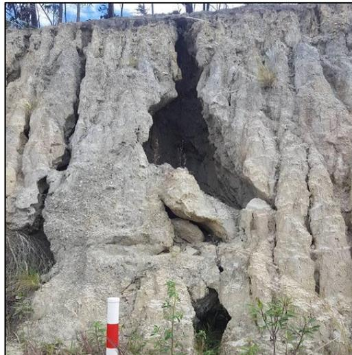
Ilustración 18. Arcillas dispersivas *piping* vía de Integración Barrial.
