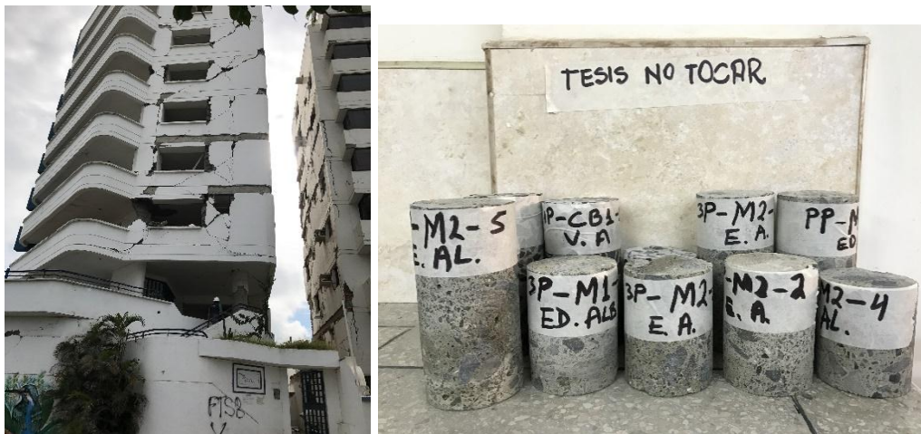
Fotografía 3. 6. Edificio Albatros – Núcleos perfilados para prueba de compresión. Fuente: El Autor. Elaboración: El Autor.
