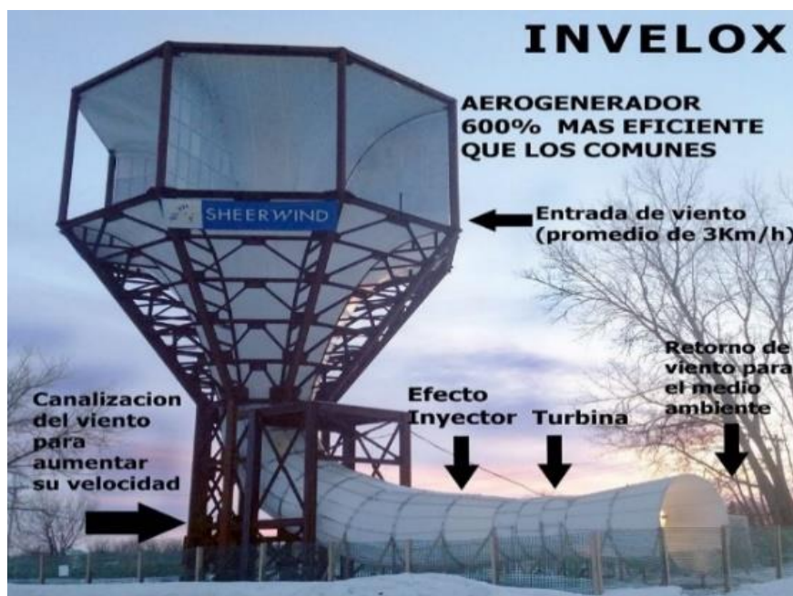
Figura 4. Vista general del aerogenerador Invelox Fuente: Tomada de (Eco Inventos, 2017) Elaboración: Eco Inventos
