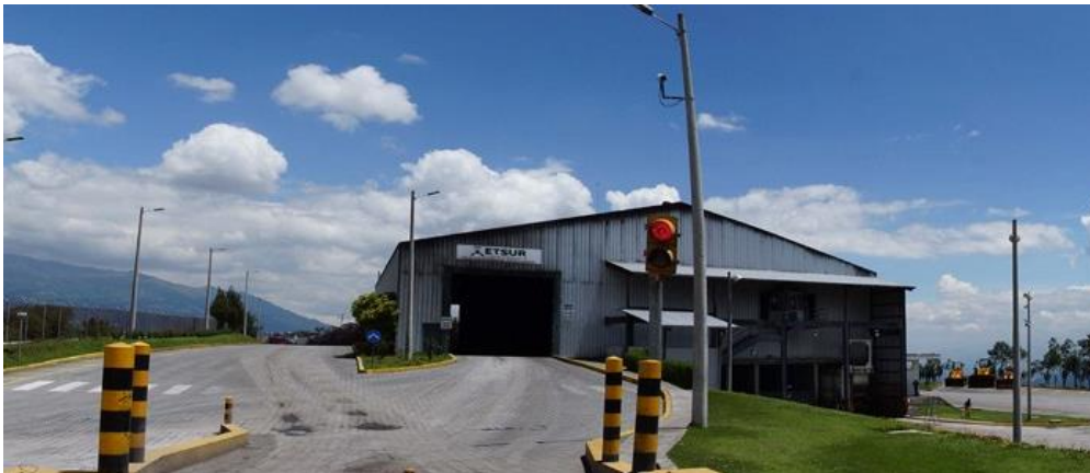
Imagen 18. Estación de Transferencia Sur Fuente: Pagina web de EMGIRS 2014 Elaborado por: Emgirs
