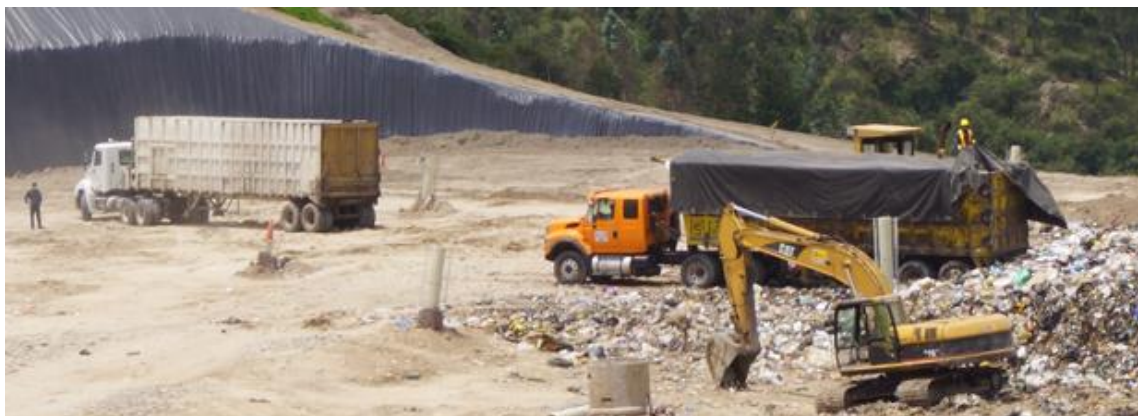
Imagen 16. Relleno Sanitario Inga Fuente: Pagina web de EMGIRS 2014 Elaborado por: Emgirs
