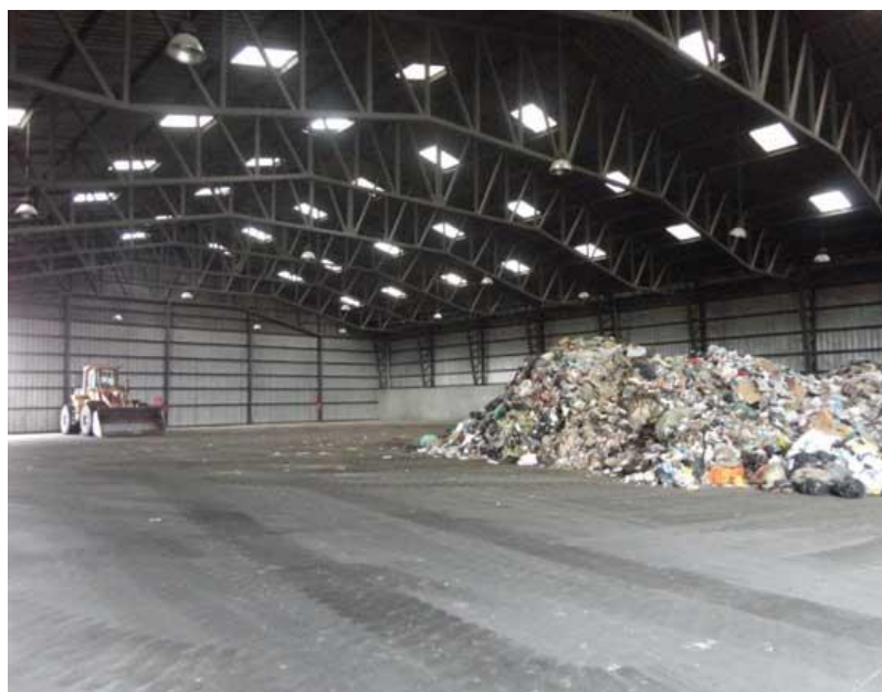
Imagen 19. Estación de Transferencia Sur Fuente: Pagina web de EMGIRS 2014 Elaborado por: Emgirs
