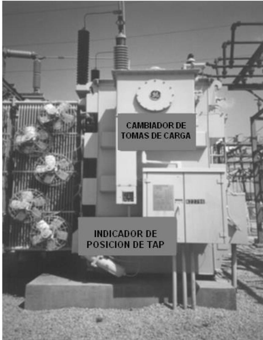
**Figura 2.1.** Transformador de cambio de tomas de carga
