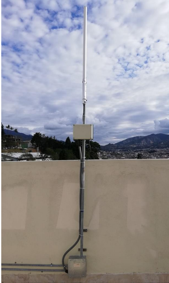
Figura 4.3.1. Gateway instalado, vista frontal. Fuente y elaborado por los autores.
