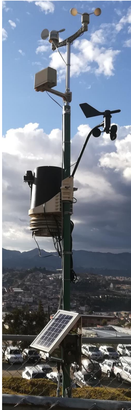
Figura 4.3.7. Instalación de Nodo de Variables Meteorológicas. Fuente y elaborado por los autores.
