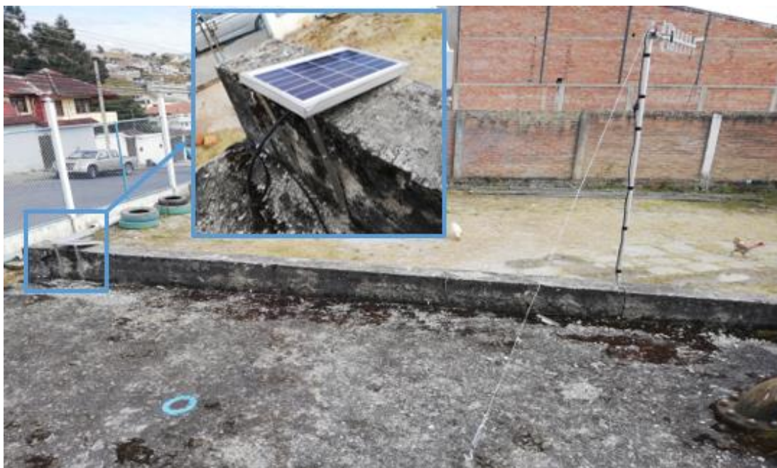
Figura 4.3.9. Instalación del panel solar y antena en la ciudadela Época. Fuente y elaborado por los autores.
