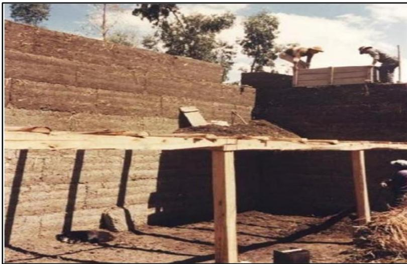
Figura 2.2. Muro de tapia en construcción
