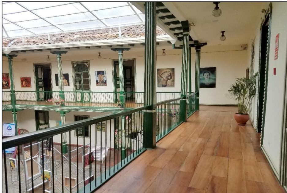
Figura 2.4. Madera como material de construcción en inmuebles coloniales (puertas, entresijos, pilares).
