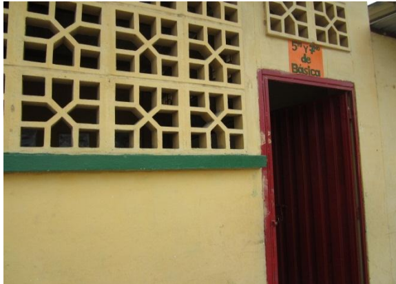
Inspección de infraestructura de escuela
