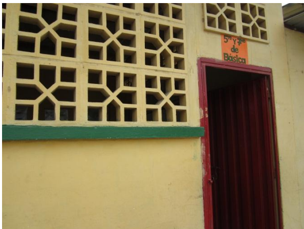
Inspección de infraestructura de escuela
