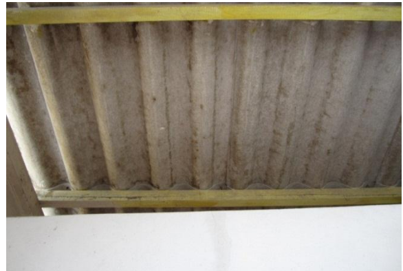
Inspección de infraestructura de escuela
