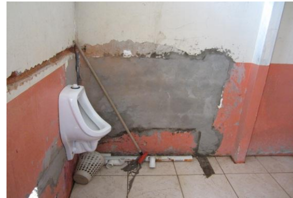
Inspección de infraestructura de escuela
