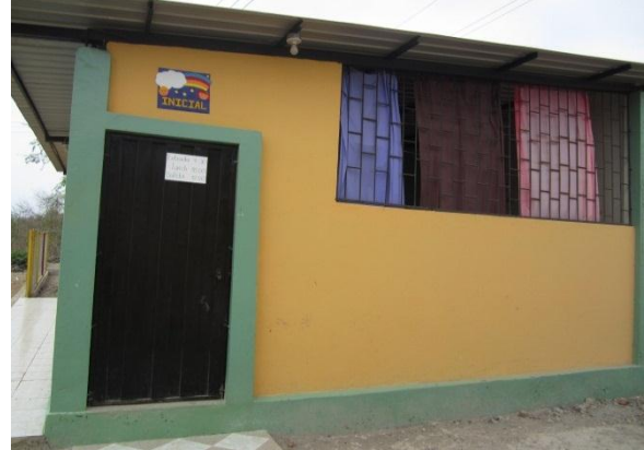
Inspección de infraestructura de escuela
