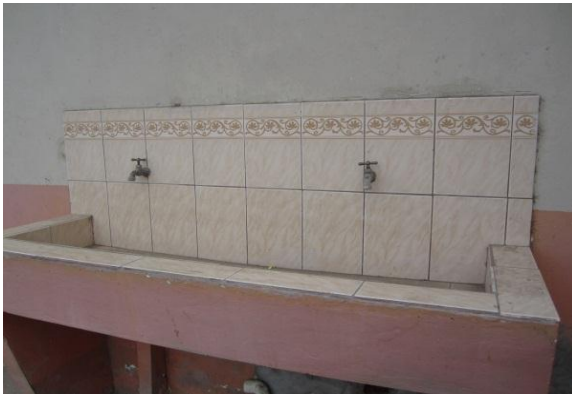
Inspección de infraestructura de escuela
