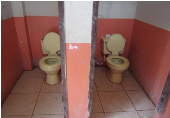
Inspección de infraestructura de escuela
