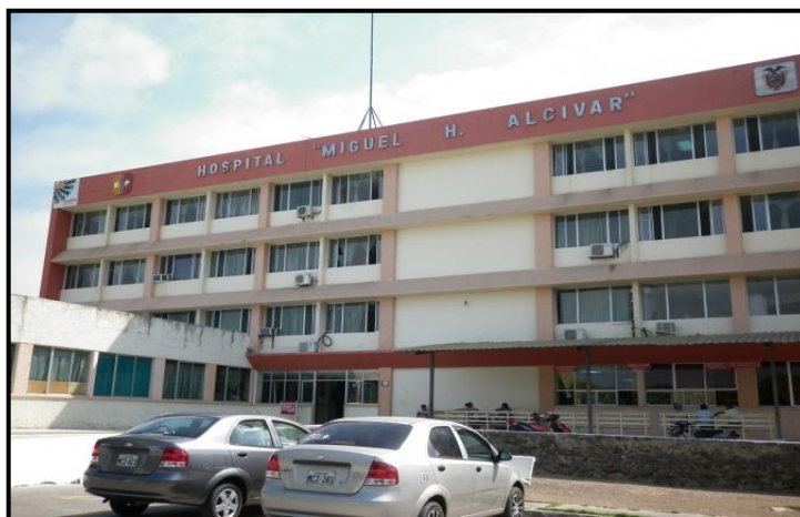
Imagen 3. Fachada del frente del Hospital Miguel H Alcívar de la ciudad de Bahía de Caráquez
