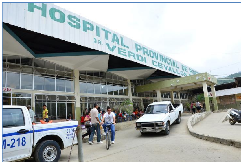
Instalaciones externas del Hospital Dr. Verdi Cevallos Balda en la ciudad de Portoviejo
