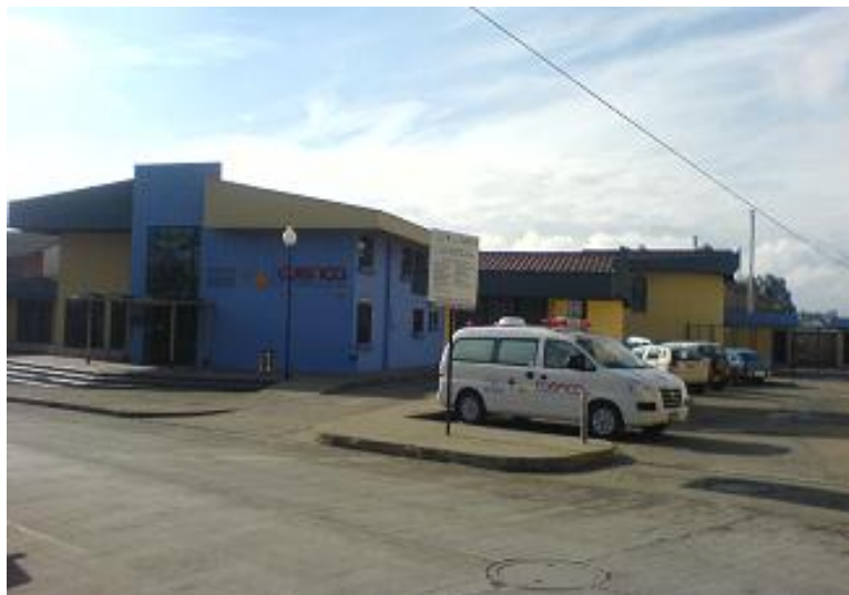
Foto N° 1: Vista frontal del Hospital Municipal Fuente: Autora
