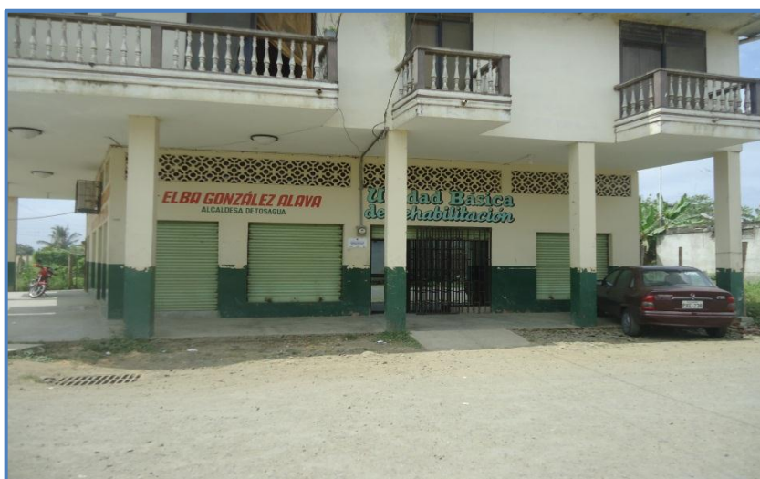
Imagen No. 3 Foto del Exterior
