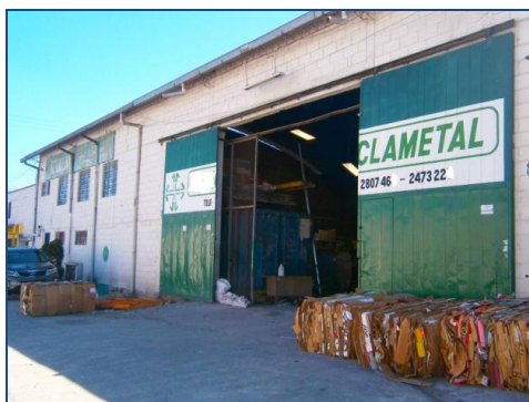
Figura 13: Instalaciones de recepción y almacenamiento de materiales del gestor tecnificado
