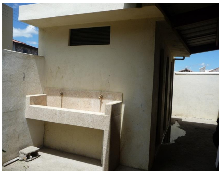
Fotografía 9. Readecuación y mejoramiento de los baños
