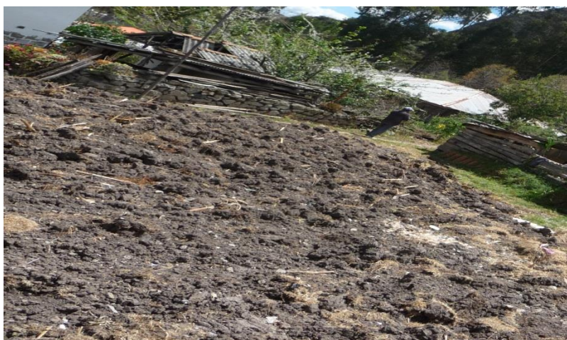
Fotografía 6. Preparación del terreno
