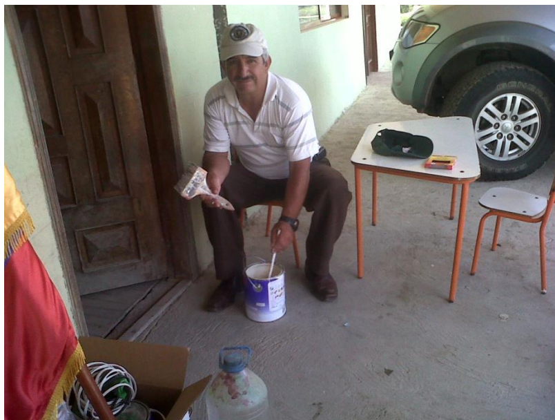
Figura 49: Arreglo y mejoramiento de la cocina que sirve como comedor
